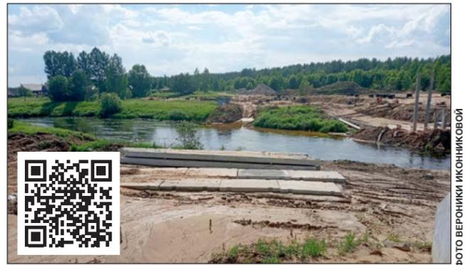
— Занимаемся устройством дорожного полотна, идет отсыпка песка, монтаж очистных сооружений, пока все в рабочем порядке.
