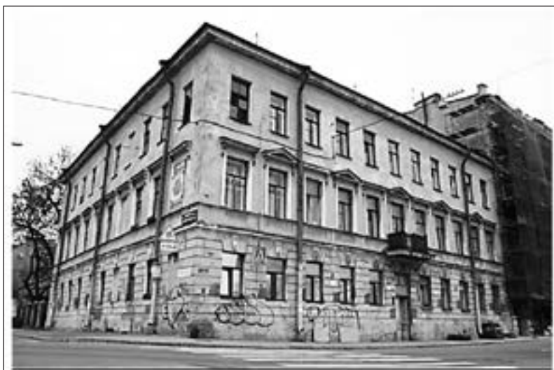
Дом К.П. Дворжака на Набережной реки Фонтанки, 141/28. Класицизм. Архитектор Ф.И. Руска. Здесь, в квартире № 3 провёл свои последние годы Ф.М. Шлейн.
