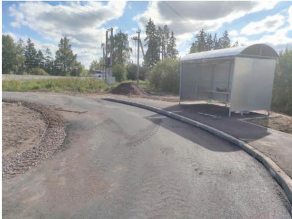
Уже уложен асфальт на дороге и на тротуаре, сделаны плавные спуски для детских колясок и велосипедов, обустроены поребрики, установлен остановочный павильон.
