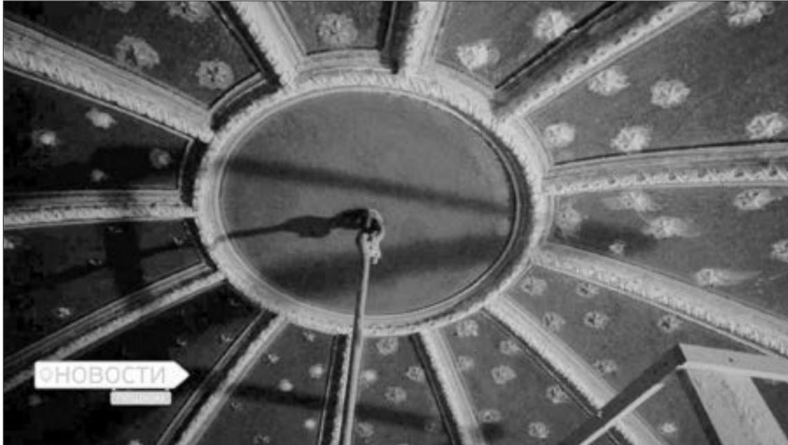
зываемую разугловочку стен и исторической штукатурки. Почему исторической? На карнизах толщина намета достигла больше 10 см, и для облегчения конструкции и достижения объема старые мастера применяли такую технологию: в тело штукатурки закладывали уголь. Мы, конечно, тоже идем по пути старых мастеров, чтобы не утяжелять широкие карнизы и для прочности их крепления.
