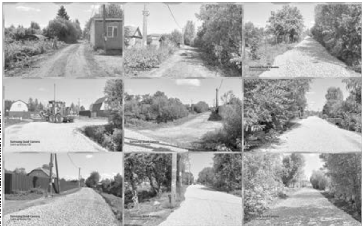
Работы по подсыпке и выравниванию дорог в пос. Новый Свет, массив 32
