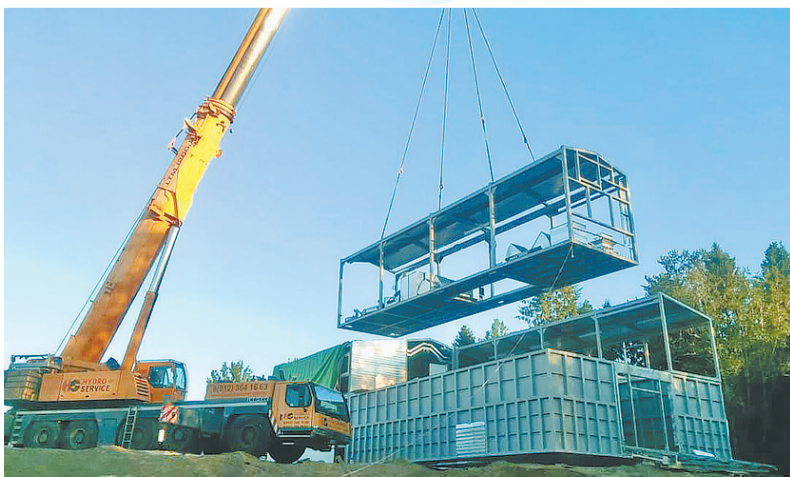
Реконструкция канализационных очистных сооружений в дер. Старая Слобода (Лодейнопольский район)
